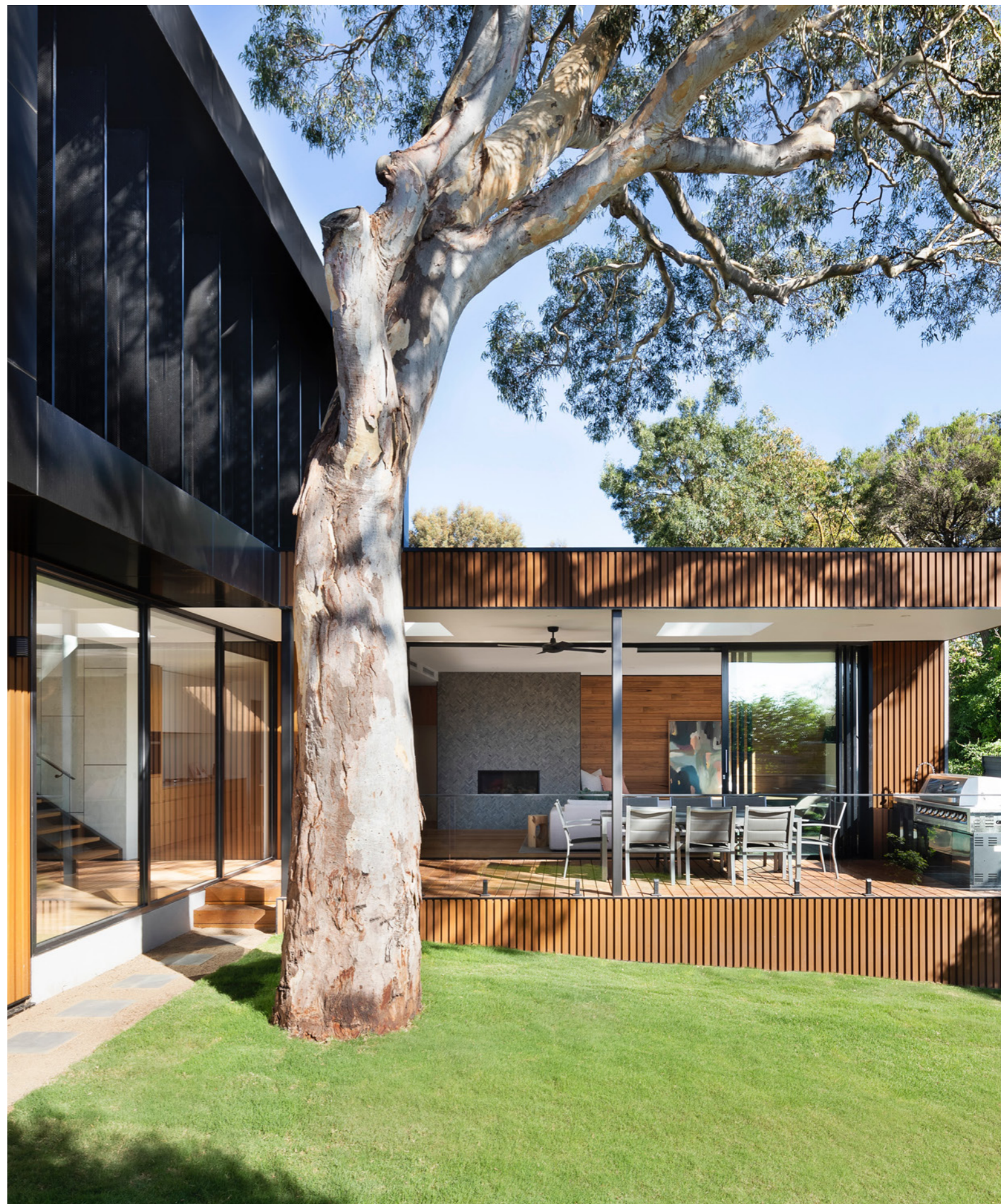
Pokud budete chtít postavit rodinný dům na pozemku, který bude územním rozhodnutím trvale odňat ze zemědělského půdního fondu, je třeba ještě zažádat o změnu územního plánu. Foto redakce
